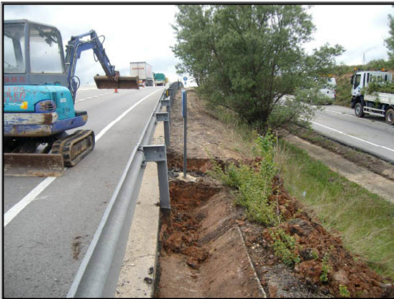
Foto 2 Cuneta revestida descubierta tras limpieza sobre la que se instaló señal
