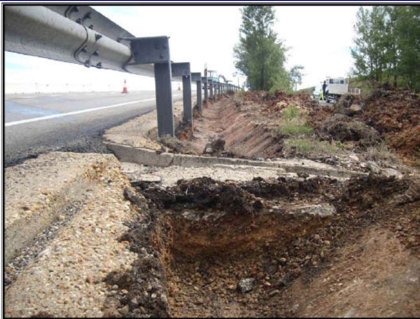
Foto 1: Cuneta revestida descubierta tras limpieza y sobre la que se colocó una bajante
