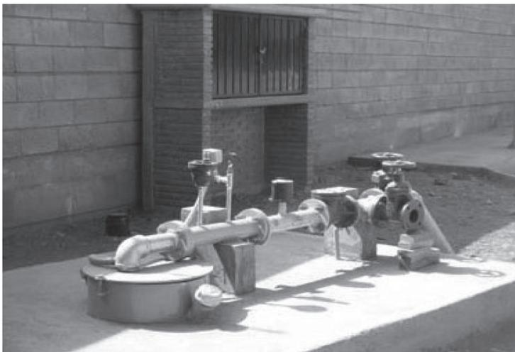
Dentro de estas instalaciones se tienen también tomas Siamesas, localizadas en puntos estratégicos en el exterior de los edificios, Gabinetes con hidrante con manguera y extintor en el interior de éstos, se consideran 2 gabinetes por nivel; Sistema de riego a base de aspersores de plástico automatizados, localizados en todas las áreas jardinadas.
